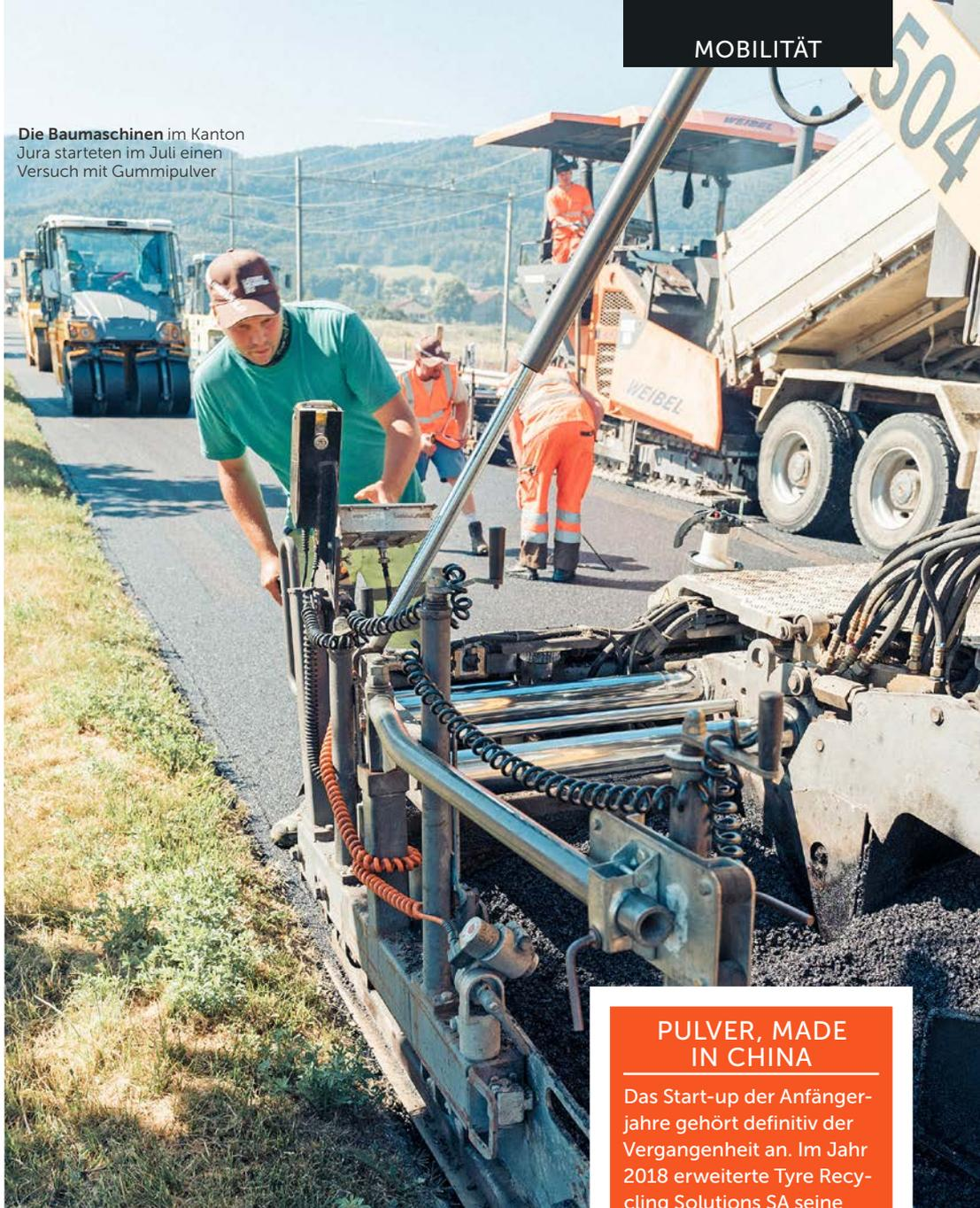
Auf der Kantonsstrasse 422 zwischen Donneloye und Prahins wurde ein 400 Meter langer Testabschnitt ausgewählt, um TyreXol™ zu erproben: eine kurvenreiche Strecke auf 700 Metern Höhe, auf der täglich rund 2500 Fahrzeuge verkehren, darunter etwa 40 Lastwagen. «Diese sogenannte Vorfahrtstrasse gestattet uns, den Werkstoff unter optimalen Bedingungen zu testen, auch bei tiefen Temperaturen und unter Einschränkungen», fährt der Ingenieur fort.
